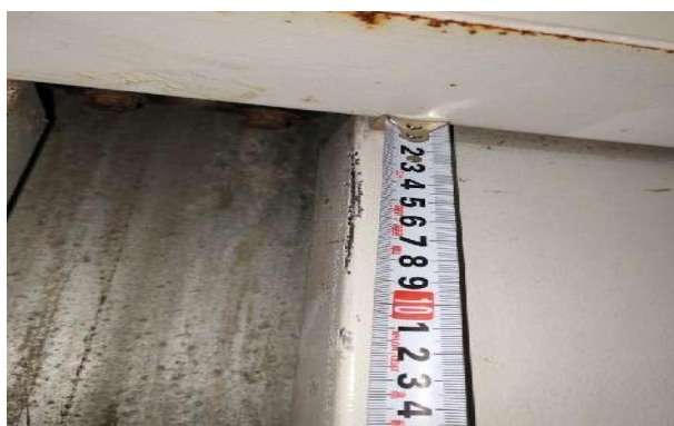
图 3 12 楼层门顶部油漆刮痕
