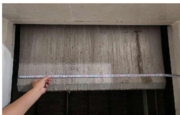
图 5 轿厢地坎低于 13 楼层门地坎
