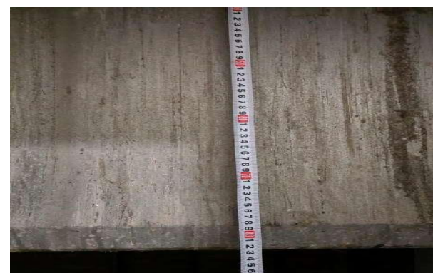
图 6 护脚板高度
