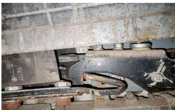
图 11 12 楼层门主门锁锁舌图
