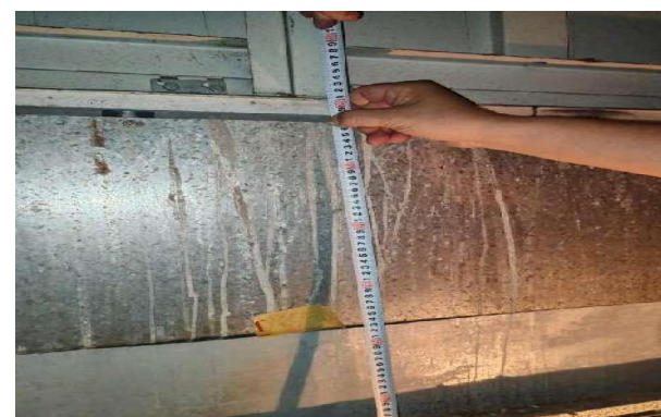
图 4 轿厢地坎高于 12 楼层门地坎
