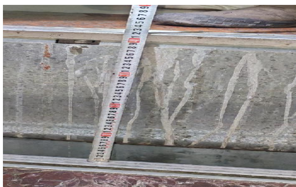
图 5 轿厢地坎低于 13 楼层门地坎
