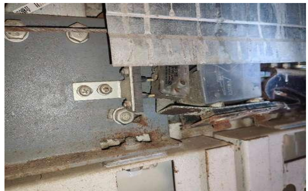
图 12 12 楼层门主门锁锁舌形变
