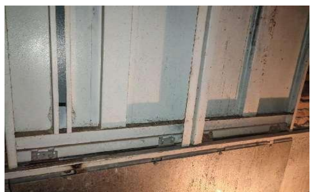
图 12 12 楼层门主门锁锁舌形变
