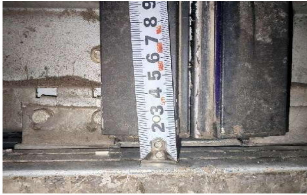
图 21 电梯层门防夹装置底部到轿厢地坎高度
