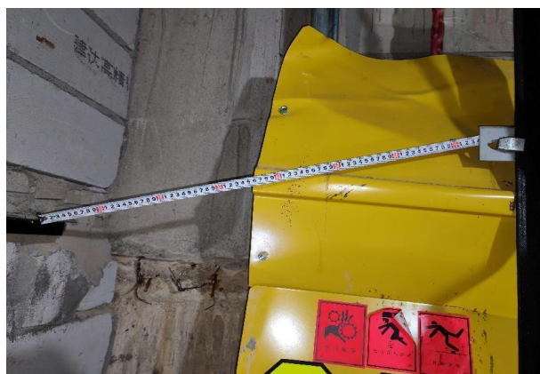
图 8 下极限开关支架与 1 楼层门地坎距离
