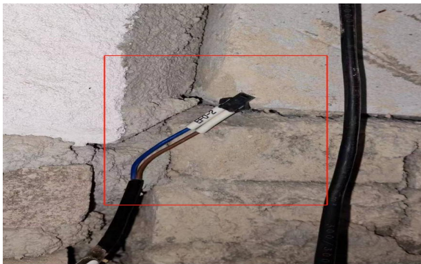
图 5 消防开关连接线与开关断开
