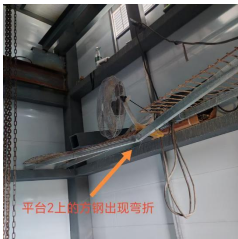
图 5 平台 2 上发现的弯折变形
