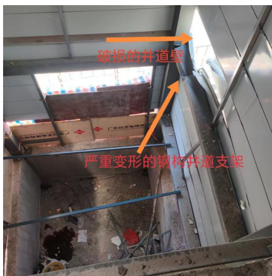
图 8 井道壁破口
