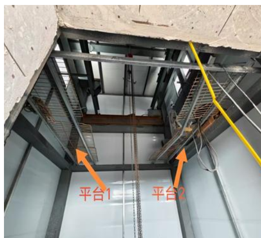
图 4 层门口上方的两个平台
