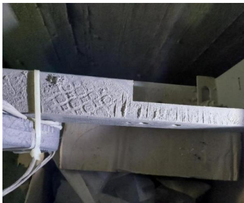
图 6 轿厢顶护栏上的脚印
