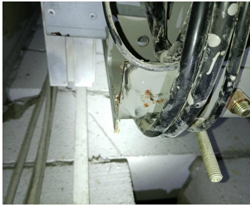
图 10 轿厢底梁左侧上的血迹
