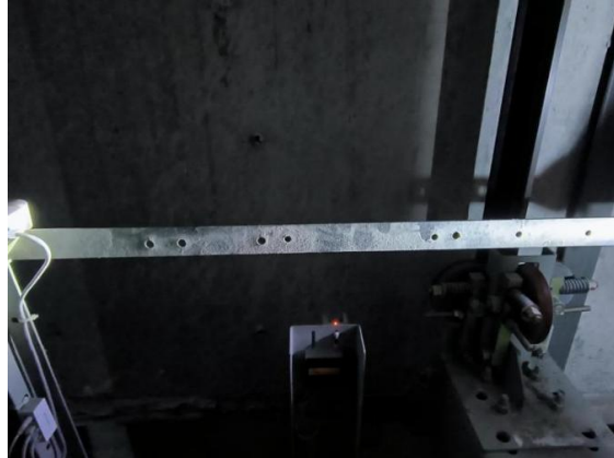
图 5 轿厢顶护栏上的掌印
