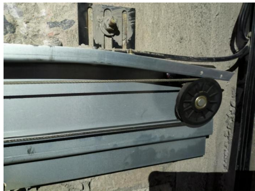
图 12 14 层层门门头变形
