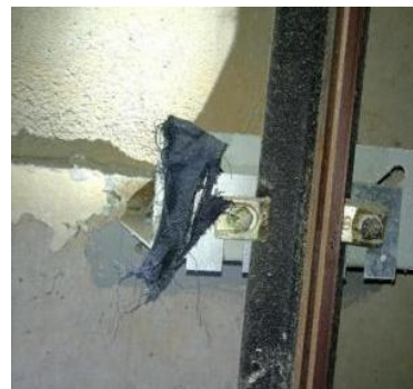
图 21 右侧轿厢导轨支架上的衣服纤维
